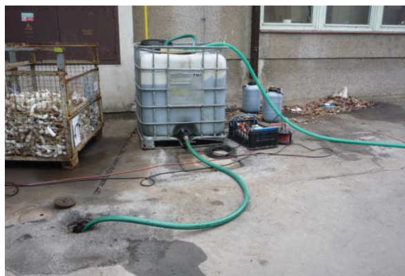
Obr. 4 Aplikace nZVI do vrtu PJ-9 10. 12. 2013
