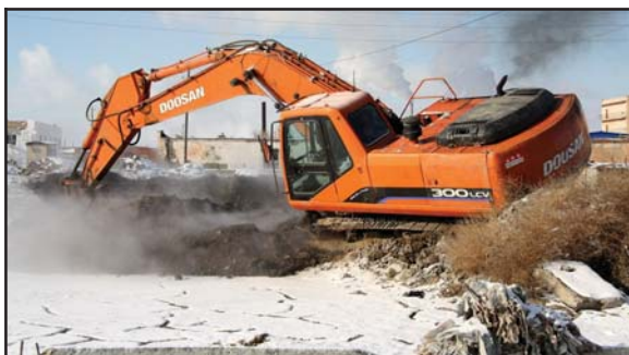
Obr. 3 Odtěžení a nakládka kontaminovaných čistírenských kalů, nevhodně deponovaných v areálu ČOV Hargia
