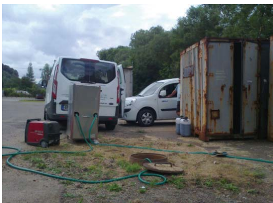
Obr. 3 Aplikace nZVI do vrtu HP-105 31. 7. 2013
