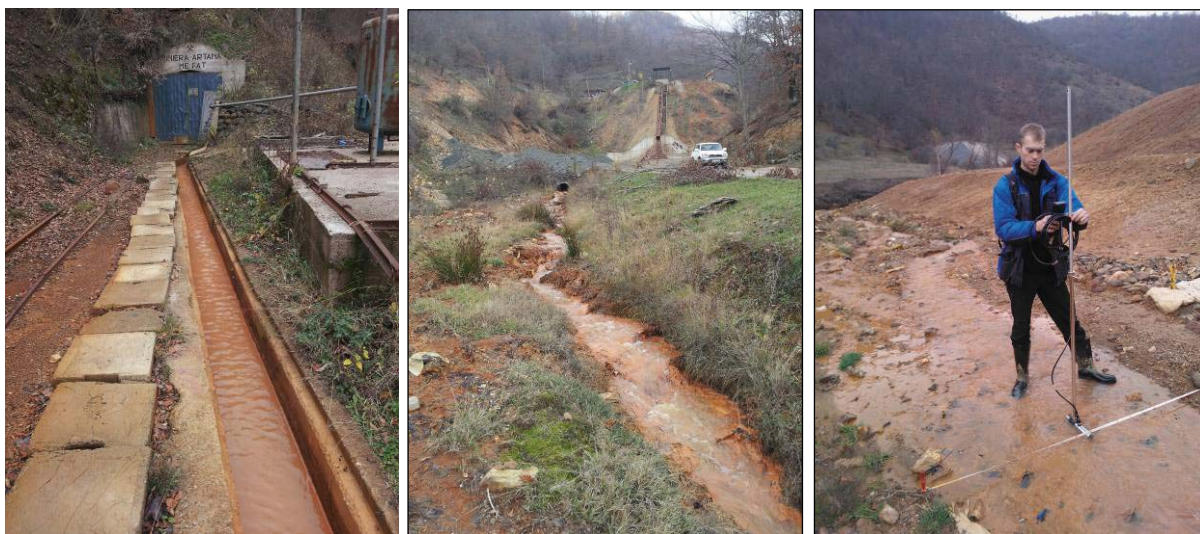
Obr. 3 Kyselá důlní voda vytékající ze štol III. V. a VI. volně meandrují přes haldu hlušiny do koryta řeky Kriva reka
